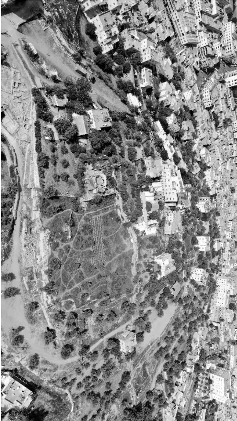
ציולוס 1.1. תל חברון – מראה כללי מכיוון דרום; צילומי רחפן: ד"ר גרשון בר כוכבא (חפירות האמונד ועופר בתחתית התמונה, חפירות בן-שלמה ואיזנברג בשמאל התמונה)
