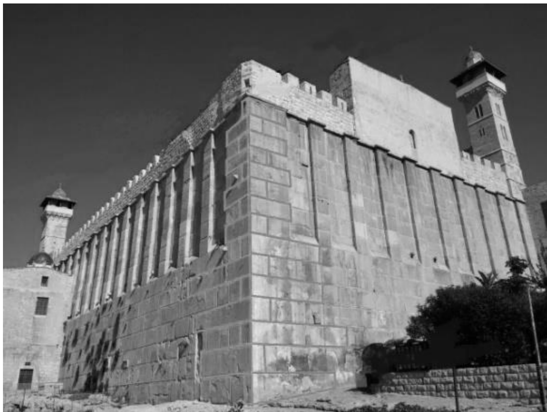
איור 11 : אבני הבנין בפינה הדרום-מזרחית במבנה מערת המכפלה. הפינה כולה, כולל החלק העליון, בנויה בשיטת "שדרת הדג".
