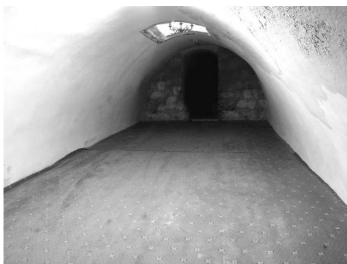
איור 11 : הקמרון בחלקו העליון של מאגר המים המערבי (גרשון בר כוכבא)
