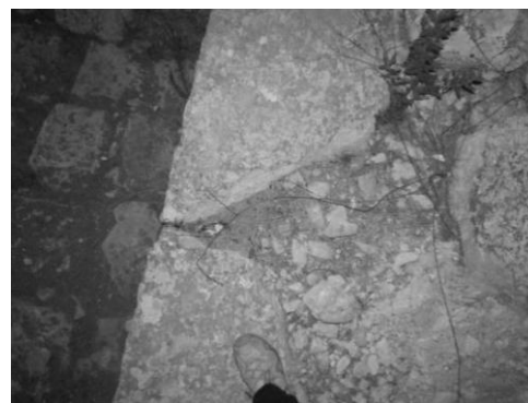
איור 27.2 – ב : באתר ממרא
