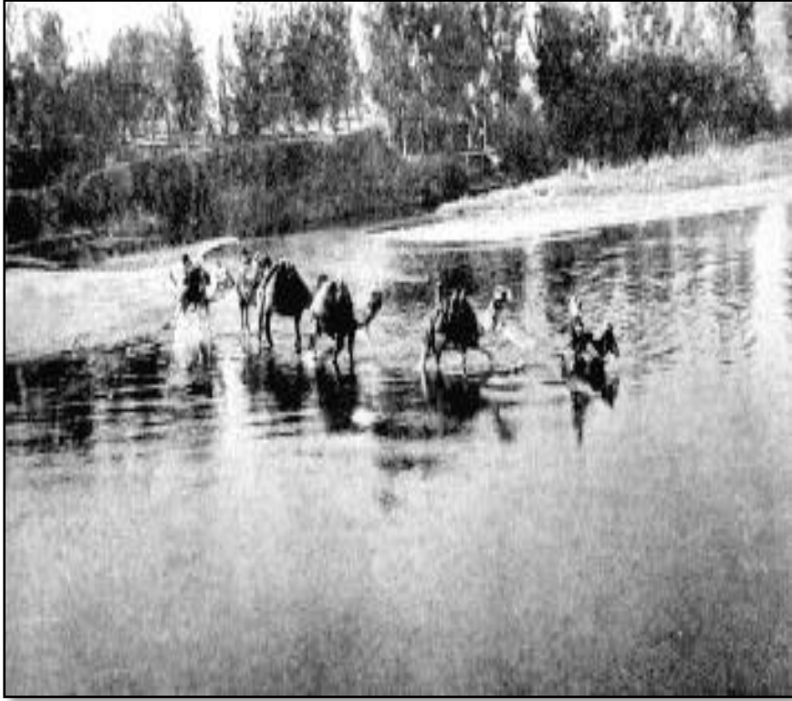
איור 48: מעבר הירדן באזור צמח (בלינקוב, 2006)
