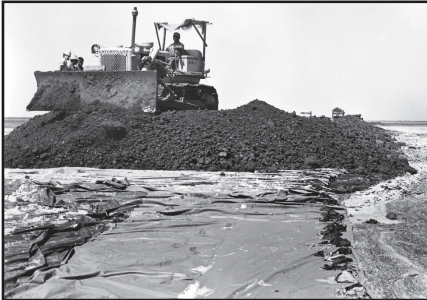
סלילת כביש הפלסטיק - דחפור דוחף את העפר על רצועת פלסטיק בין בלוזה לתעלת סואץ - תש"ל
